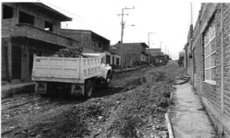
Sustituyendo para ello 510 m.l. de red hidráulica y la misma longitud de tubería sanitaria de 10", realizando tomas y descargas domiciliarias, pozos de visita y cajas de válvulas para su correcto funcionamiento, además de 3,978.00 m2 de empedrado ahogado en concreto.
