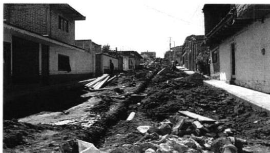
Introduciendo 228 m.l. de red hidráulica de pvc de 3" y la misma longitud de tubería sanitaria de 10", realizando tomas y descargas domiciliarias, pozos de visita y cajas de válvulas para su correcto funcionamiento, además de 1,641.77 m2 de empedrado ahogado en concreto
